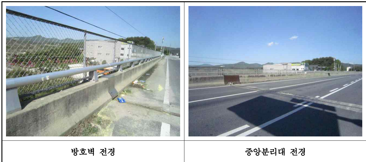
【사진 3.20】 방호벽 및 중앙분리대 전경
