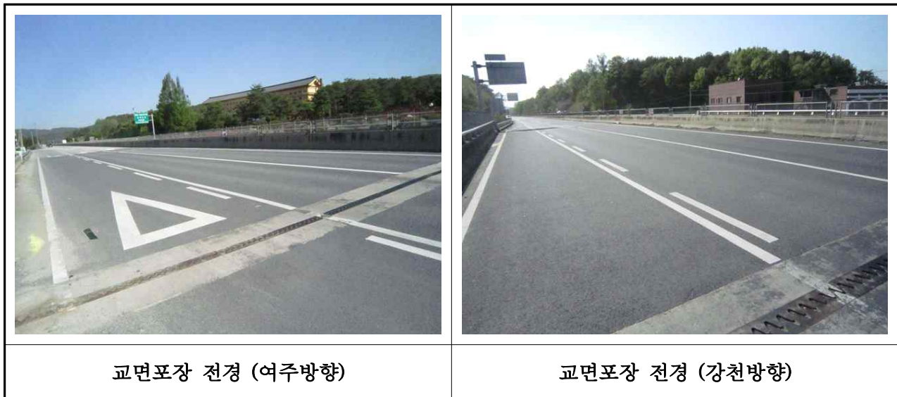
【사진 3.16】 교면포장 전경
