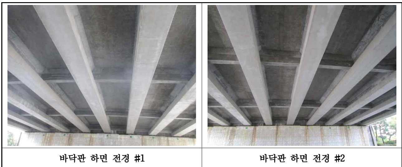
【사진 3.2】바닥판하면 전경
