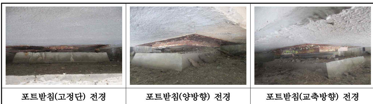
【사진 3.9】 교량받침 전경
